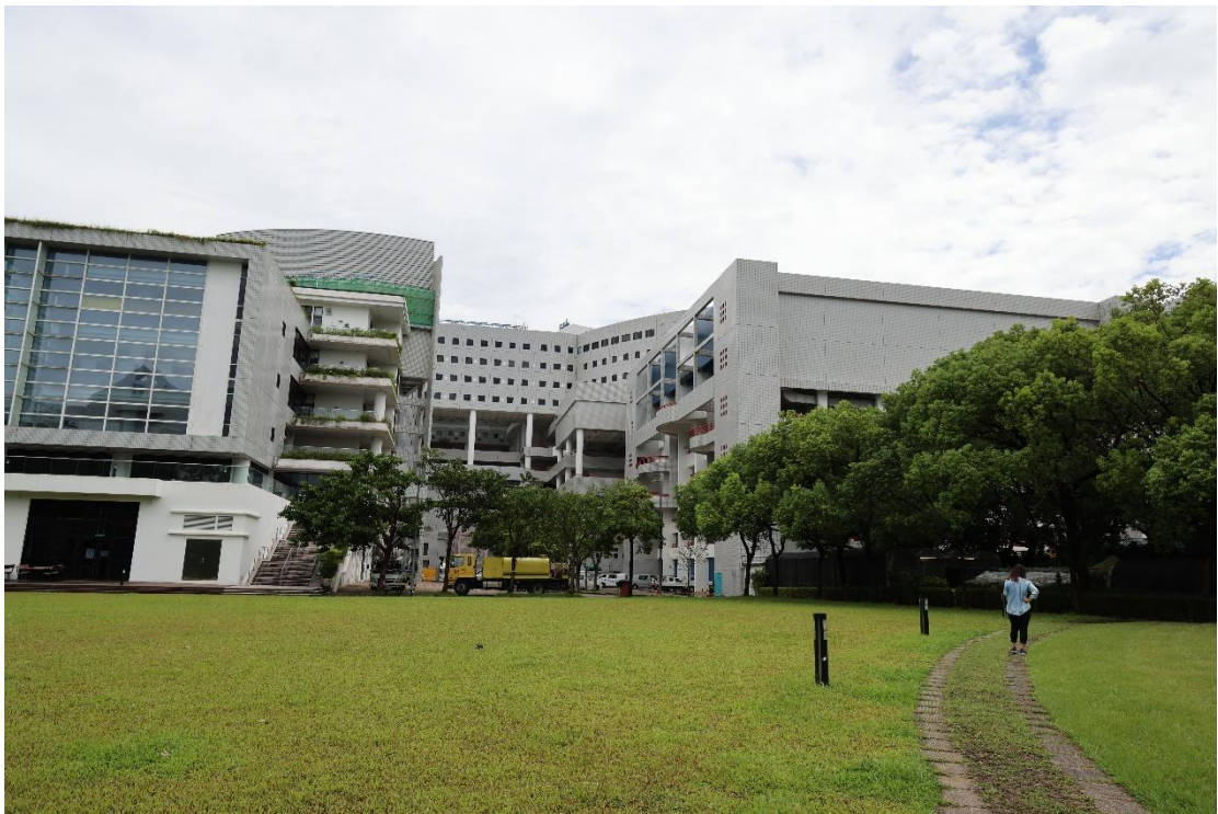
图 27 草坪（右侧为学术大楼，左侧为图书馆）
